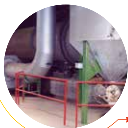
Contrôle de la siccité (taux d'humidité) et du taux de poussières
